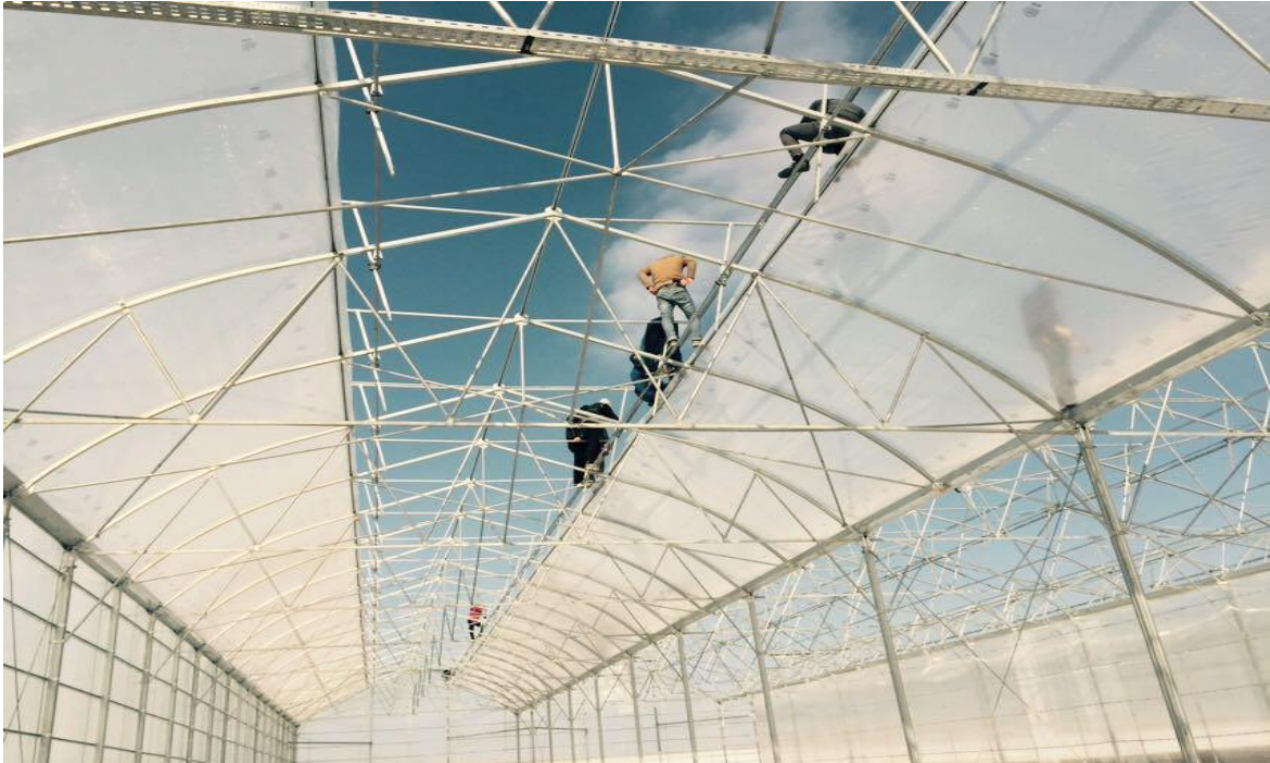
Resim 23 Plastik örtü malzemesi montajı
