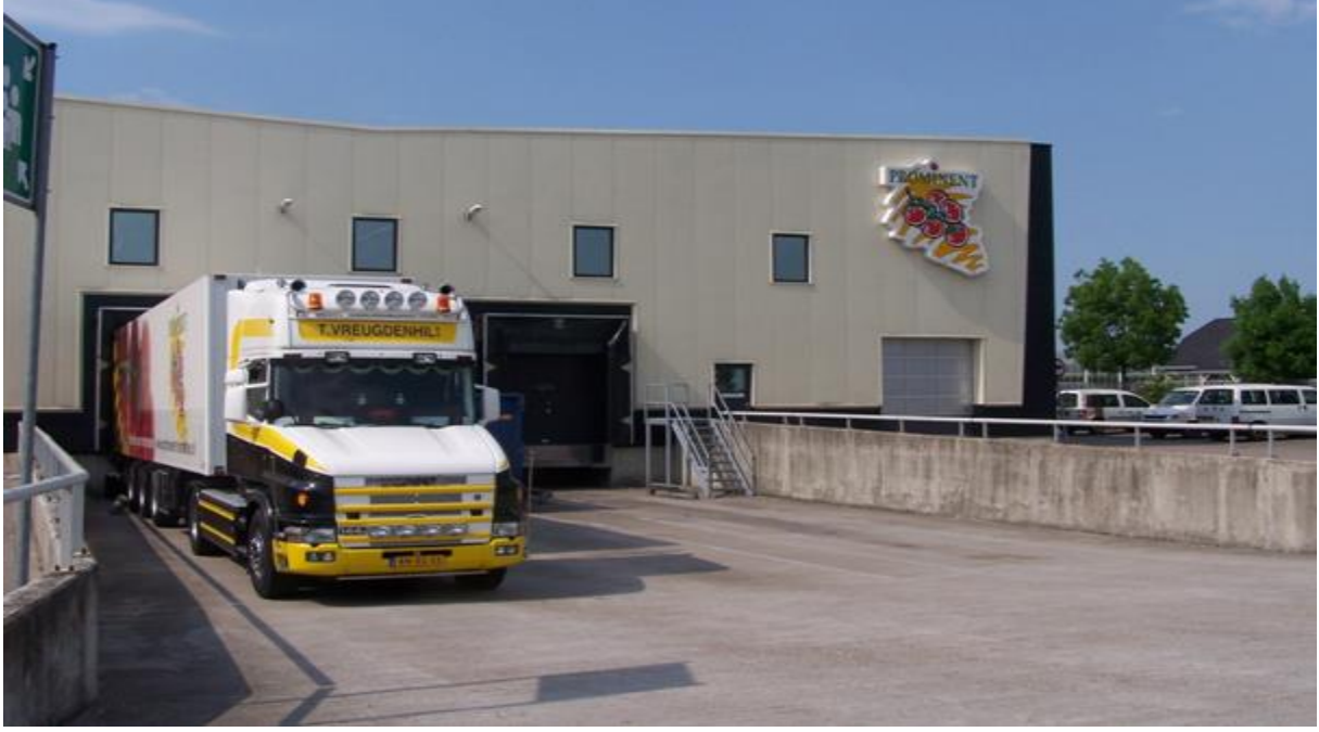
Resim 72 Tır Yükleme Rampası
