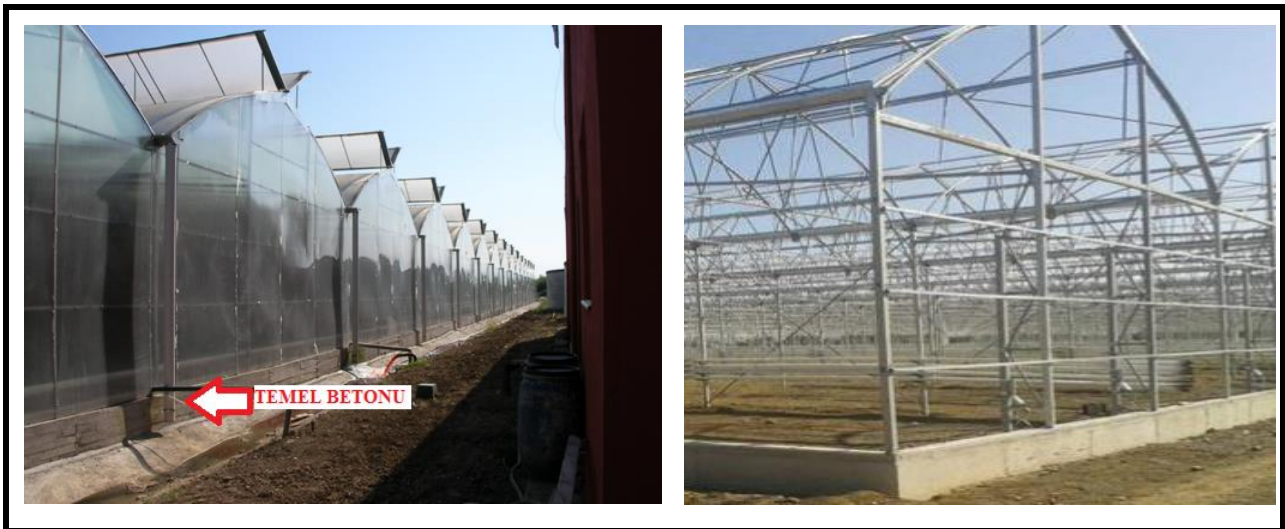
Resim 5 Sera çevre, temel ve yan perde betonu örnek
