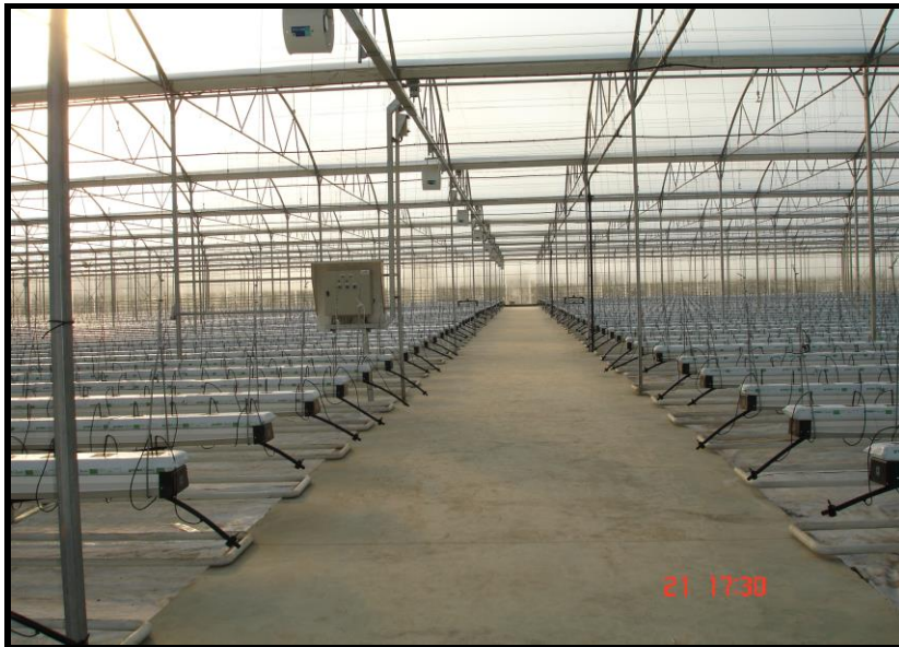
Resim 40 Drip Sulama Sistemi
