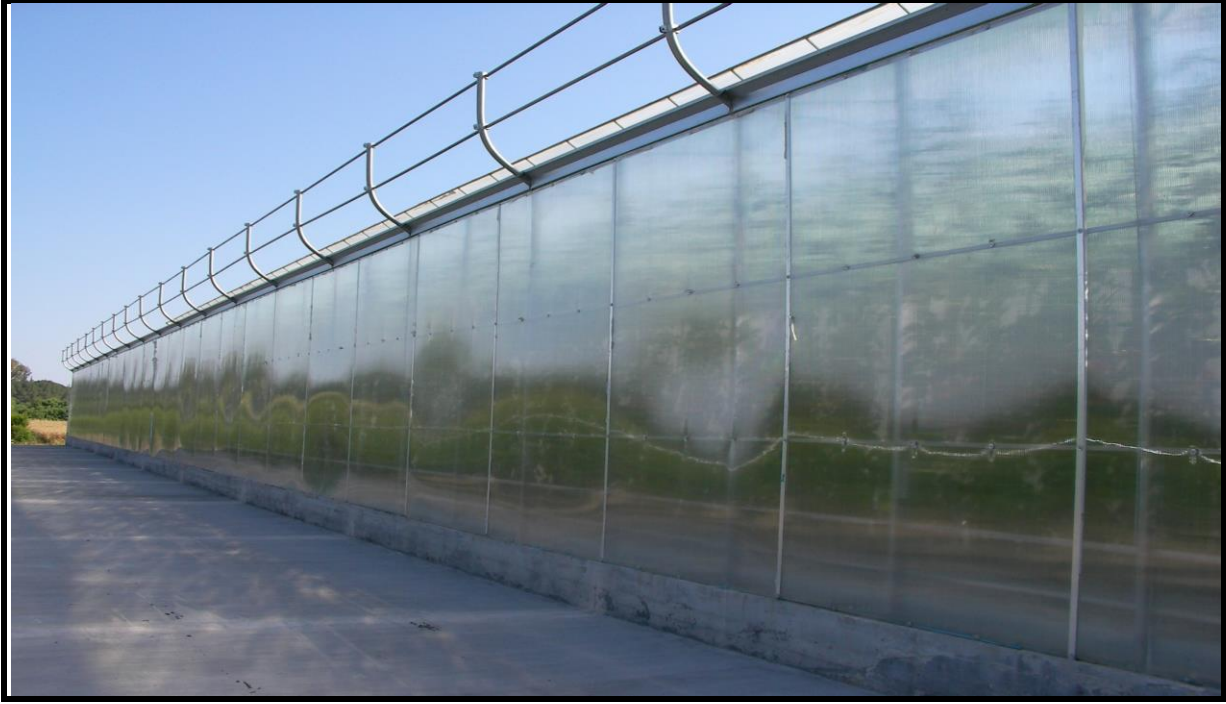
Resim 6 Sera çevre, temel ve yan perde betonu örnek
