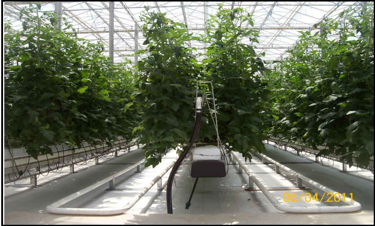
Resim 54 Raylı Sistem Isıtma ve Bitki Isıtma Sistemi
