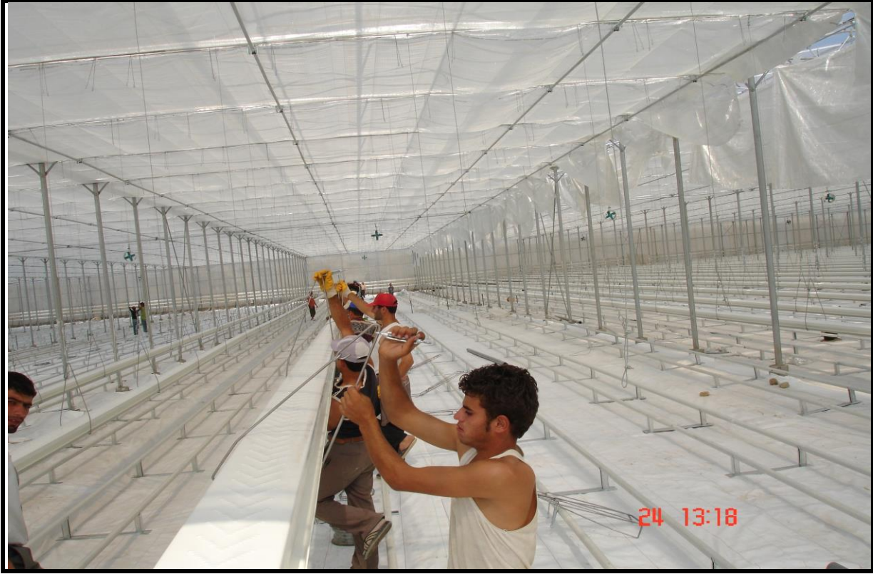
Resim 34 Bitki Yatağı Montajı
