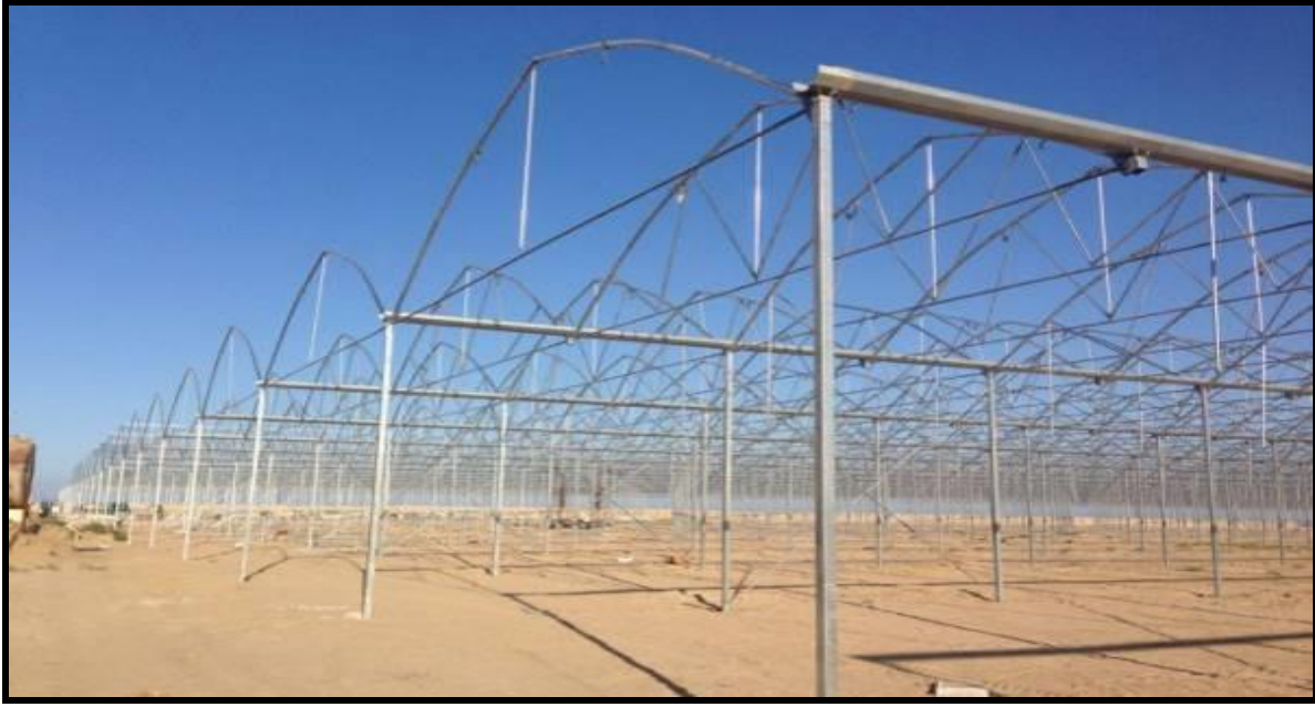
Resim 10 Direkler, Yaylar, Çatı Görünümü Örnek
