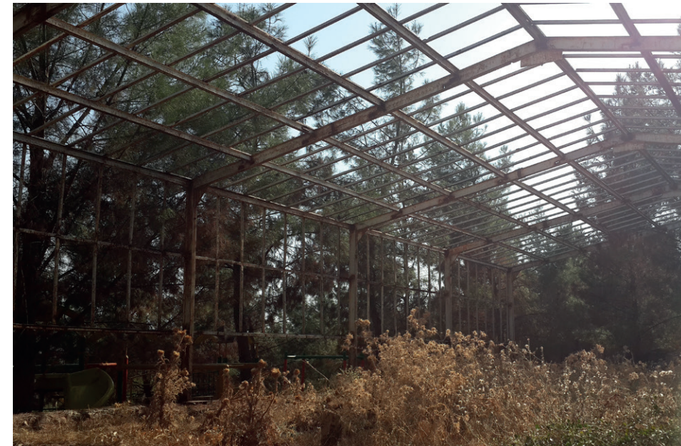
Şekil 3.3.4: Botanik Bahçesi'nde bulunan ve sadece çelik strüktürü yapılmış olan sera.
