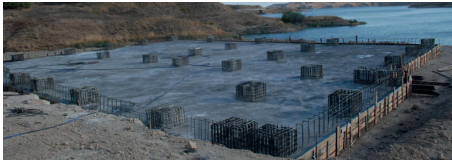
Şekil 1.3.1.6.1: Gazihan Dede Su Sporları Merkezi İnşaatı, Kaynak: adiyaman.gov.tr
