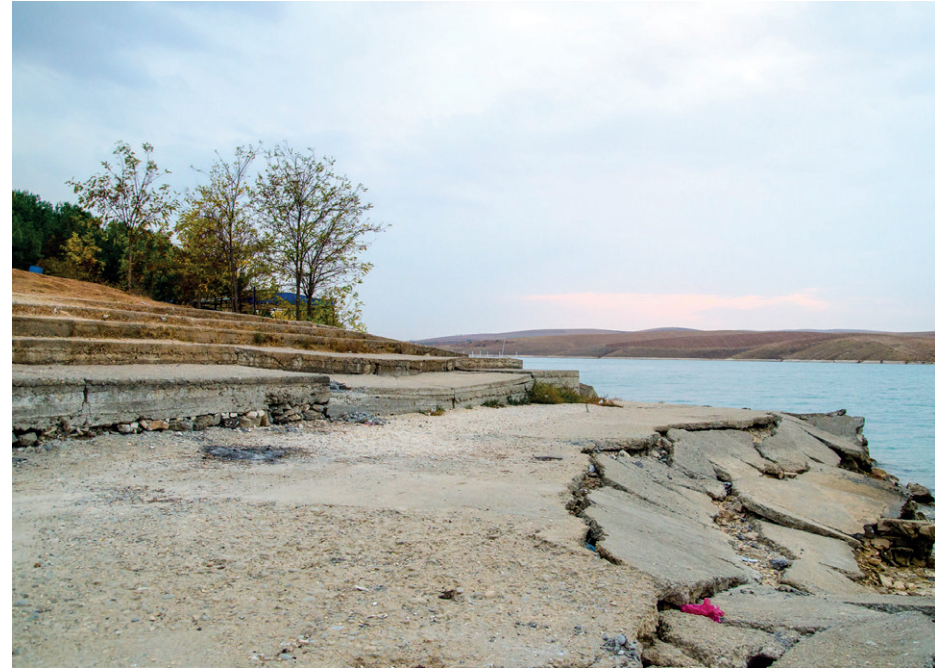
Şekil 3.4.6: Beton zeminden oluşmuş kıyı yolu.
