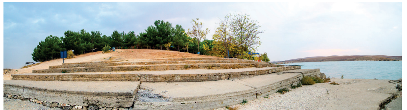
Şekil 3.4.7: Burunda amfiteatro yapmak üzere oluşturulmuş beton platformlar.
